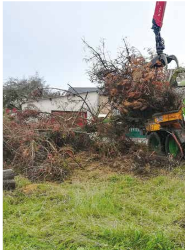
Les troncs ont préalablement été débordés pour être accessibles au broyeur
